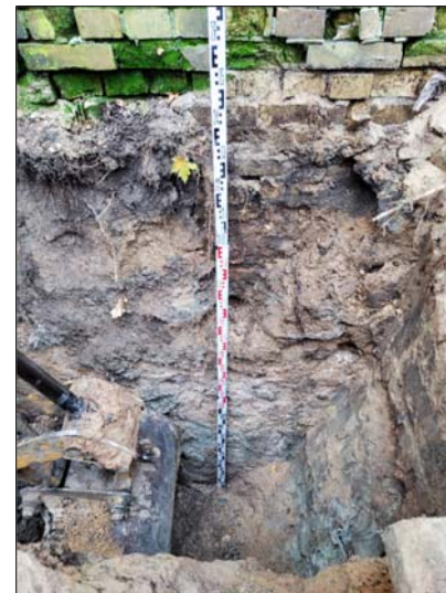
2. pav. Pastato pamatai šurfe ŠR. 2.
