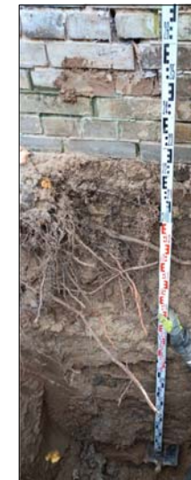
3. pav. Pastato pamatai šurfe ŠR. 3.
