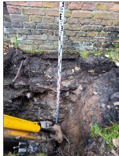
1. pav. Pastato pamatai šurfe ŠR. 1.
